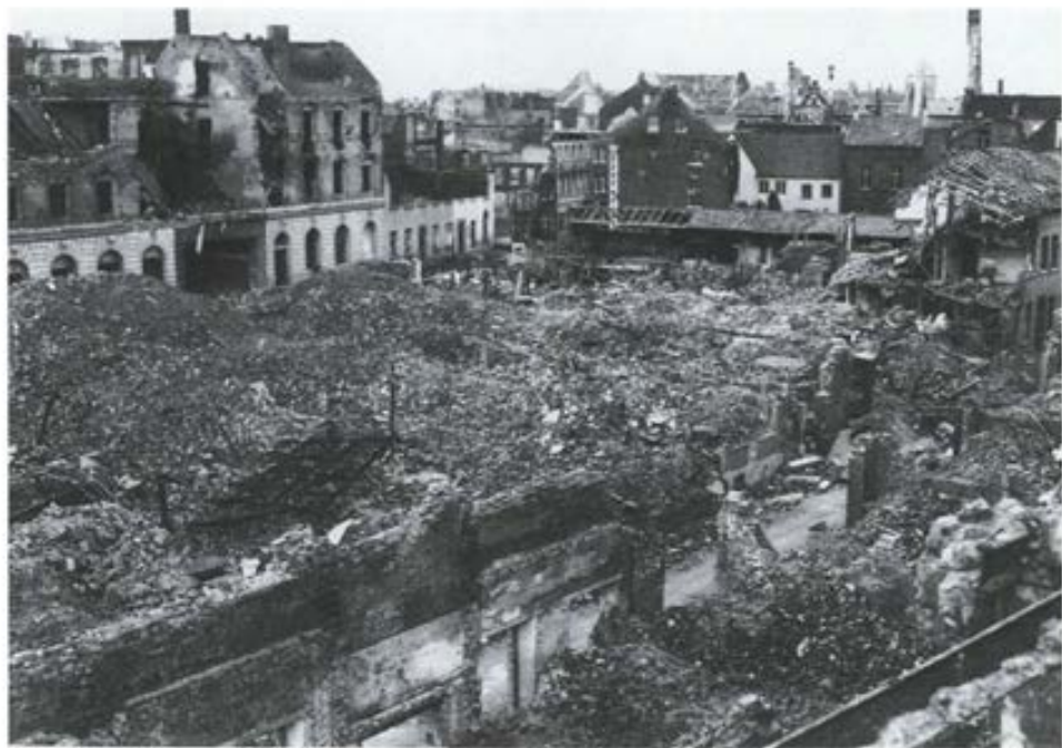
Une partie de la destruction causée par les bombardements à Munich-Gladbach au début de 1945 (PL 42341)
