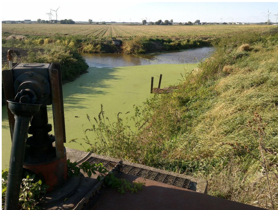
Figure 110: Dans Rondeau Bay (10RBY), une digue et un système de pompe régulent le niveau d'eau près des terres agricoles.
